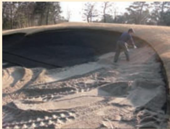
**3** 茨城県高萩産の砂を補充し、均一に敷きならします。砂の厚さは約15センチで多少の偏りがあっても敷設したマットが出にくいようになっています。ちなみに高萩産の砂は、関東のゴルフ場で最も使用されている砂です。特徴は、程よい粒径の粗さで透水性も良く目玉になりにくい砂質です。また、色合いも白すぎず夏場の日光の反射で目が疲れることもありません。
