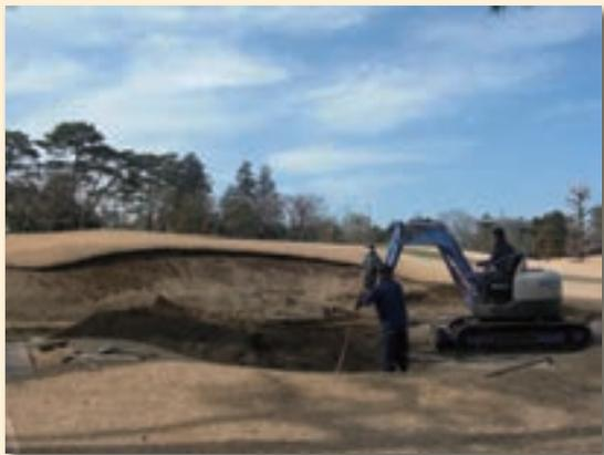
**1** 現在の砂には土が多量に混ざり込んでいるため、バンカー内の全ての砂を排出します。
