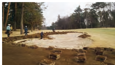
フェアウェイバンカー改修中
